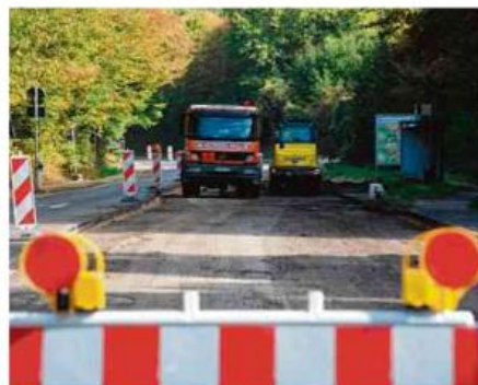
Bei Fräsarbeiten im ersten Bauabschnitt stellte sich heraus, dass sich die Fahrbahn in einem noch schlechteren Zustand als erwartet befindet.
