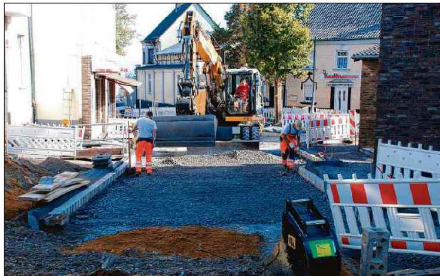
Gut voran kommt die Baukolonne. Ab Montag soll die Kreuzung asphaltiert werden.
